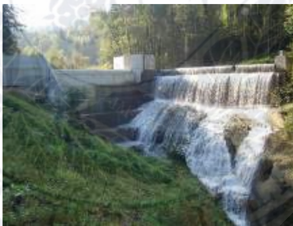
Рисунок 3. 8 Каскад малої гідроелектростанції О́лава II
