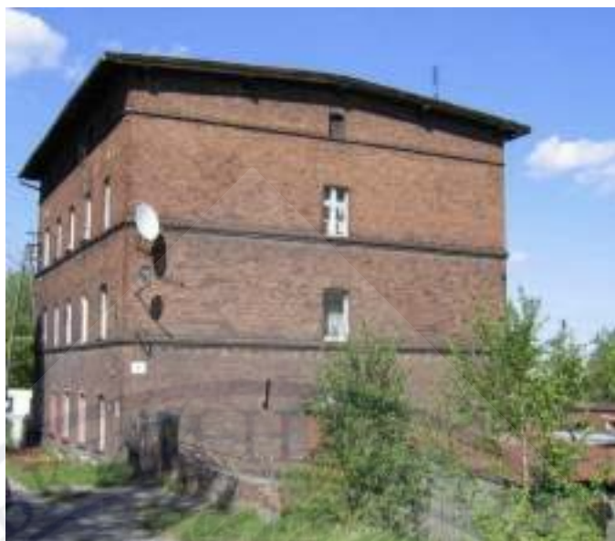
Рисунок 3.9 Мала гідроелектростанція Оława II, (вул. Великий звіринець на каналі Млинівка річки Одра)
